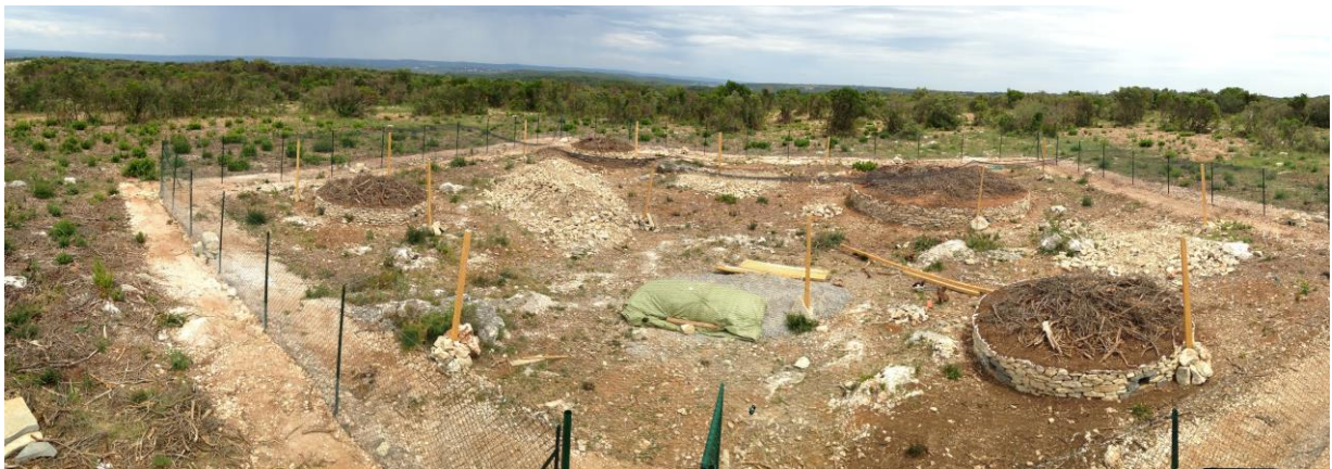
Chantier de construction des garennes au lieu-dit "le Pavillon" (source : SMGG)
